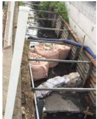
流れを止め、ポンプで先を送り排水し工事をする
